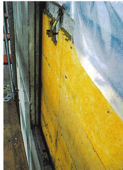
Aufgehängte Betonfassade, oben das Aufhängesystem.
