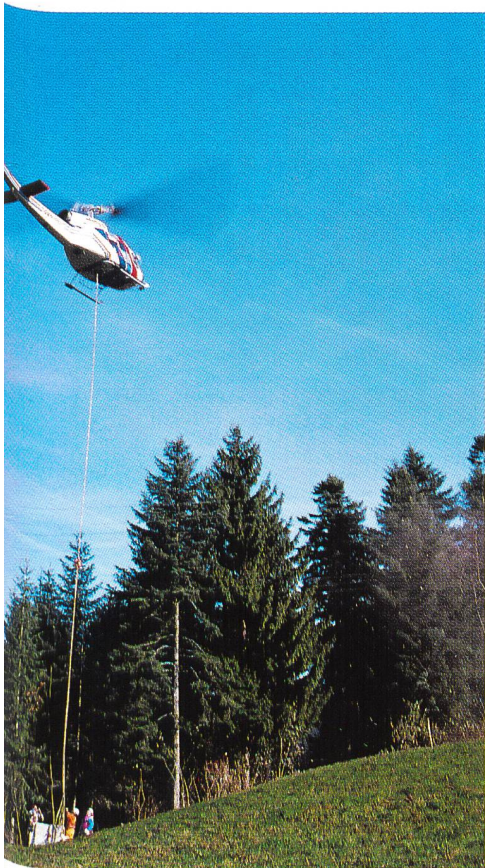
Bild 3. Ein Antennenmast wird per Heli angeliefert.
