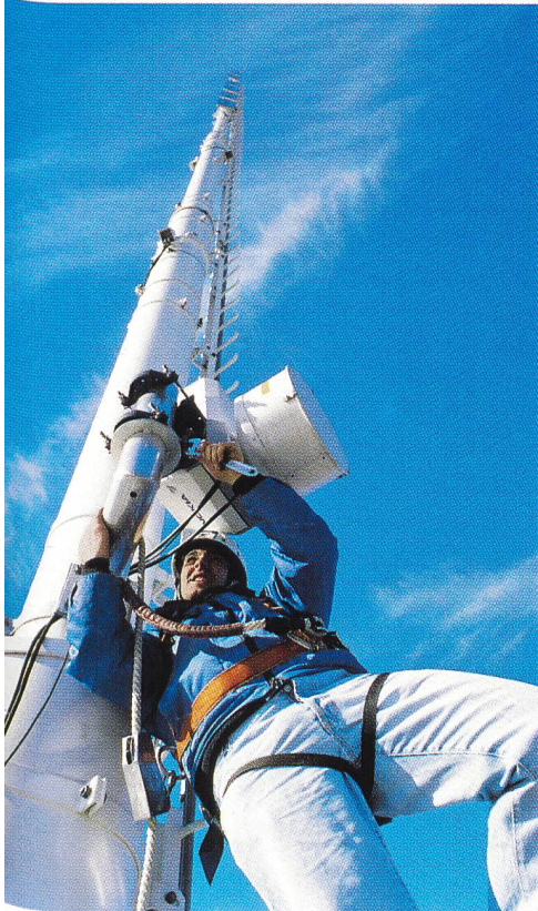
Bild 2. Montage einer Natel-Antenne auf dem Gebäude der Mobilcom, Telecom PTT, in Ostermündigen BE.
