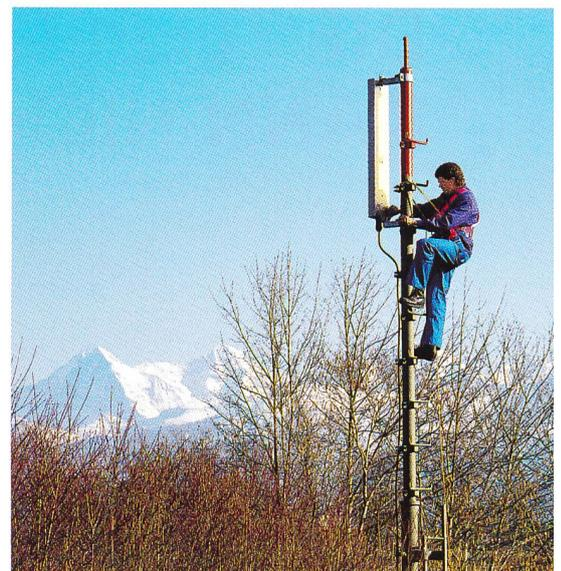
Bild 5. Montage der Outdoor-Anlage (Sender/Empfänger für Natel).
