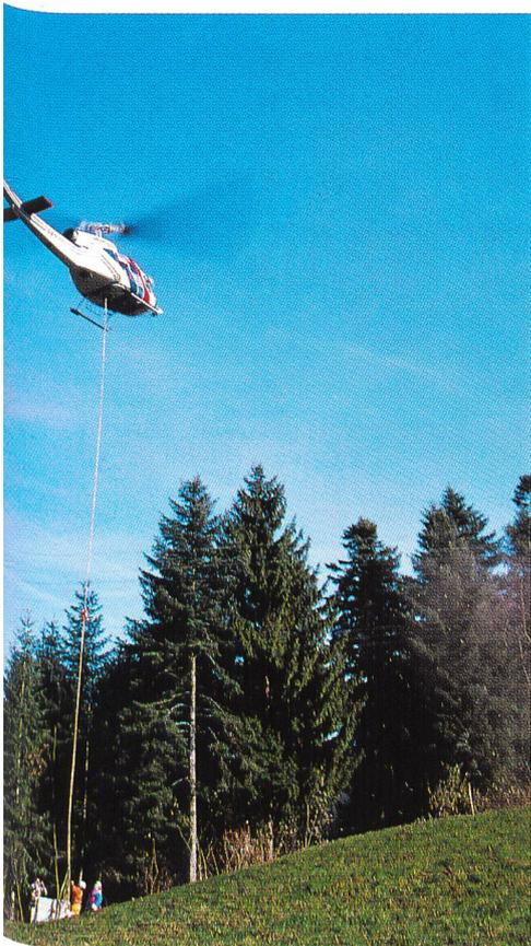
Bild 3. Ein Antennenmast wird per Heli angeliefert.
