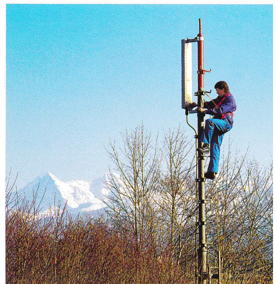
Bild 5. Montage der Outdoor-Anlage (Sender/Empfänger für Natel).
