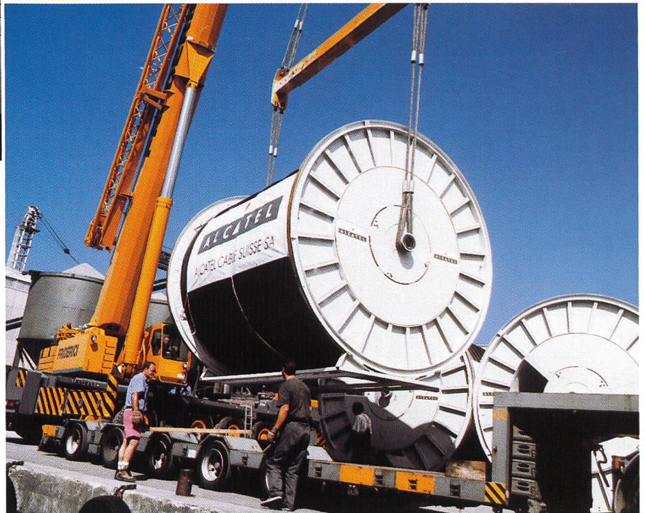
▶ Kabelhaspel beim Verlad mit Pneukranen.
