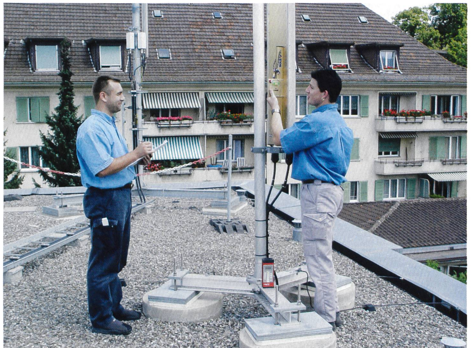
Bild 2. Distanzen und Antennenwinkel werden exakt ausgemessen, Gebäudematerialien ermittelt und Dachfenster, Oberlichter sowie zugängliche Orte, OMEN und OKA fotografiert. Es entsteht ein umfassendes NIS-Aufnahmedossier, das für die anschließende NIS-Berechnung unverzichtbar ist.
