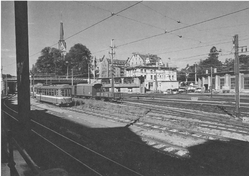
Abbildung 1: Das Areal nordwestlich des Hauptbahnhofes St. Gallen
