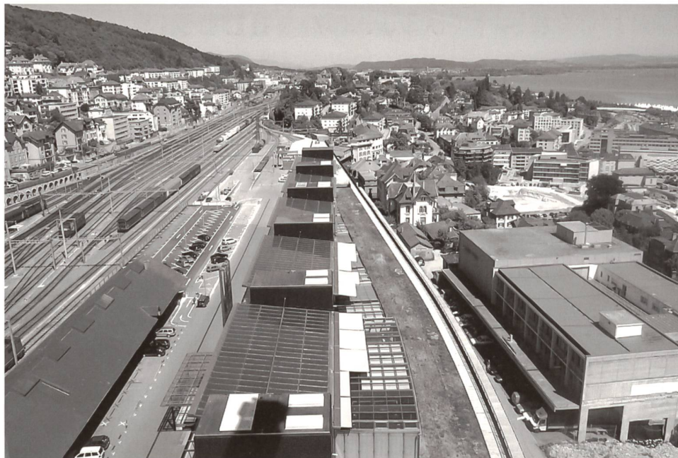
Vue du quartier depuis la tour de l'OFS, actuellement en construction
