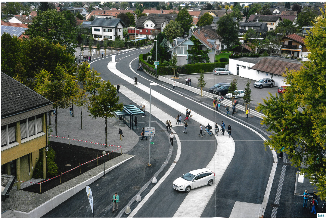
[ABB. 2] Ortsdurchfahrt Wollfurt nach der Umgestaltung. (Foto: Fritz Kobi)
