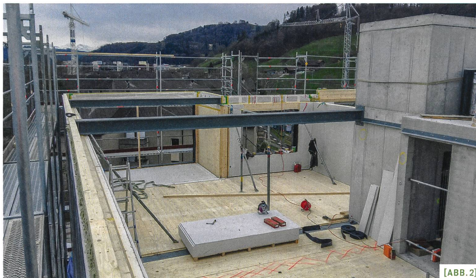
[ABB. 2] Rund um den Liftschacht werden die Elemente, die in Ramsei vorproduziert wurden, platziert. (Foto: zVg)
