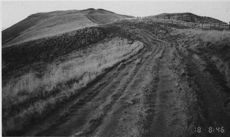
Mam Tor wird jährlich von 2 Millionen Personen bestiegen. Die Erosion bis zur Sanierung betrug 20 cm im Jahr.
