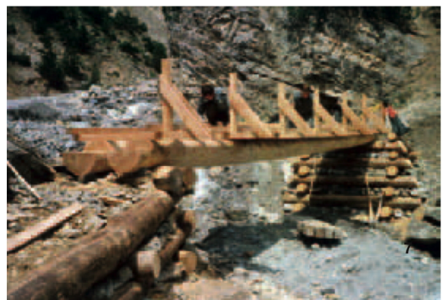
Ein eingespieltes Parkwächterteam erstellt in wenigen Tagen qualitativ hochwertige Brücken wie hier in der Val da Stabelchod.
