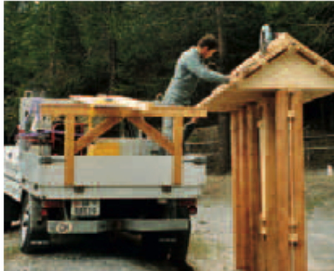
Montage der neuen Eingangstafeln auf Parkplatz 3. Die Tafelsysteme wurden in Winterarbeit vorfabriziert und im Frühjahr versetzt.
