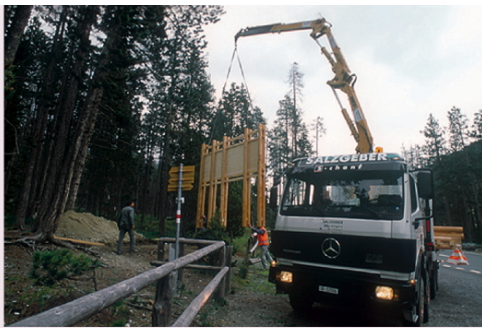
Die im Winter vorfabrizierten Gestelle für die neuen Informationstafeln werden in die vorbereiteten Fundamente versetzt.
