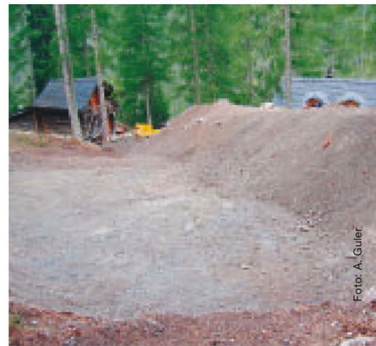
Neu errichteter Damd zur Ablenkung von Murgängen oberhalb des Blockhauses Cluozza
