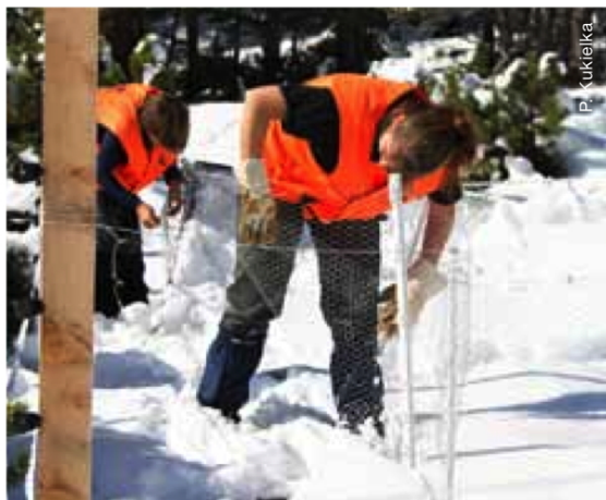
Reparaturarbeiten an Zäunen nach Wintereinbruch.
