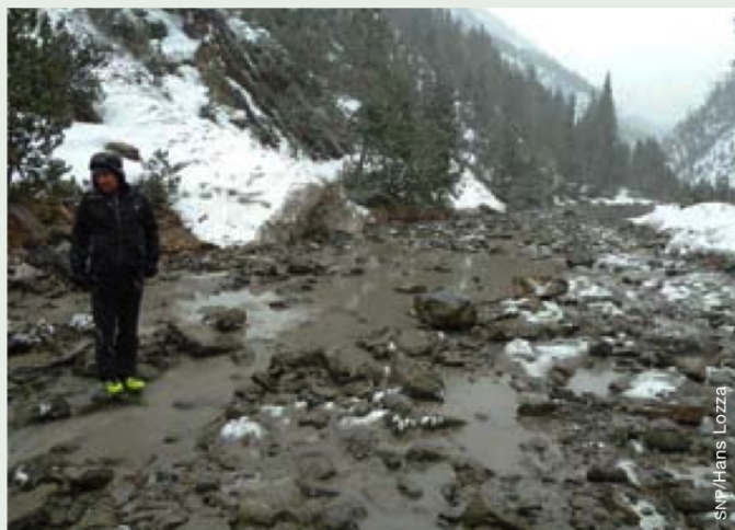
Nach einer technischen Panne Ende März 2013 wurde der Spöl unterhalb der Staumauer Punt dal Gall mit einer Schlammsschicht überdeckt.
