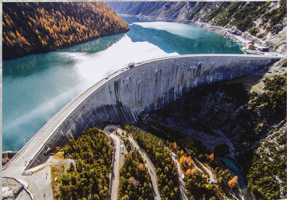
Abb. 1 Stauwand Punt dal Gall und Stausee Livigno
