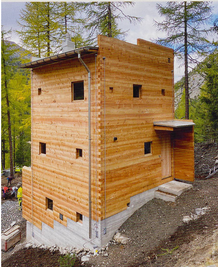
Der neue, in Strickbauweise erstellte Wohnturm ist seitlich versetzt hinter der bestehenden Hütte platziert.
