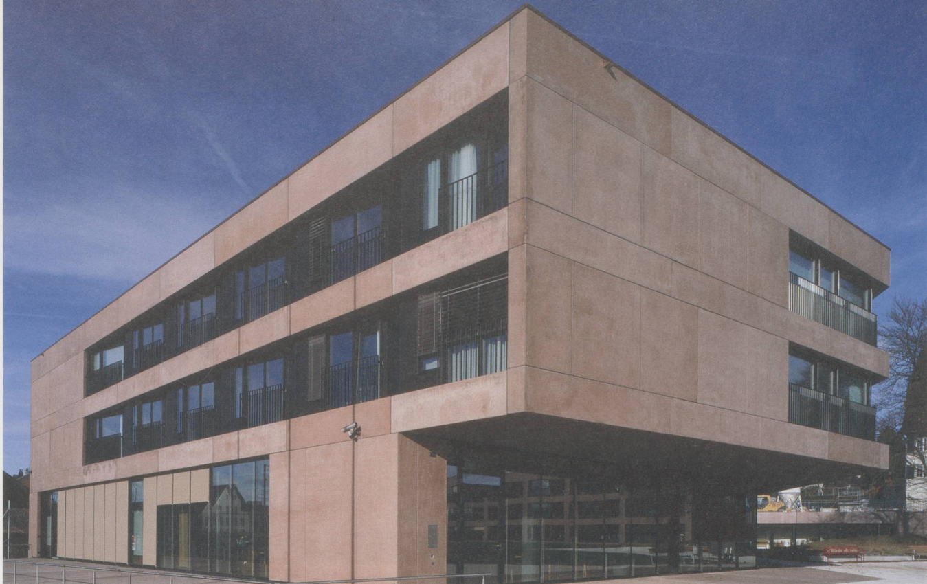
Le centre pour personnes âgées Sophie Guyer, à Pfäffikon (ZH): «Le marché a besoin de structures qui permettent de vivre de façon autonome le plus longtemps possible, grâce au soutien des proches ou des services d'aide à domicile.»
