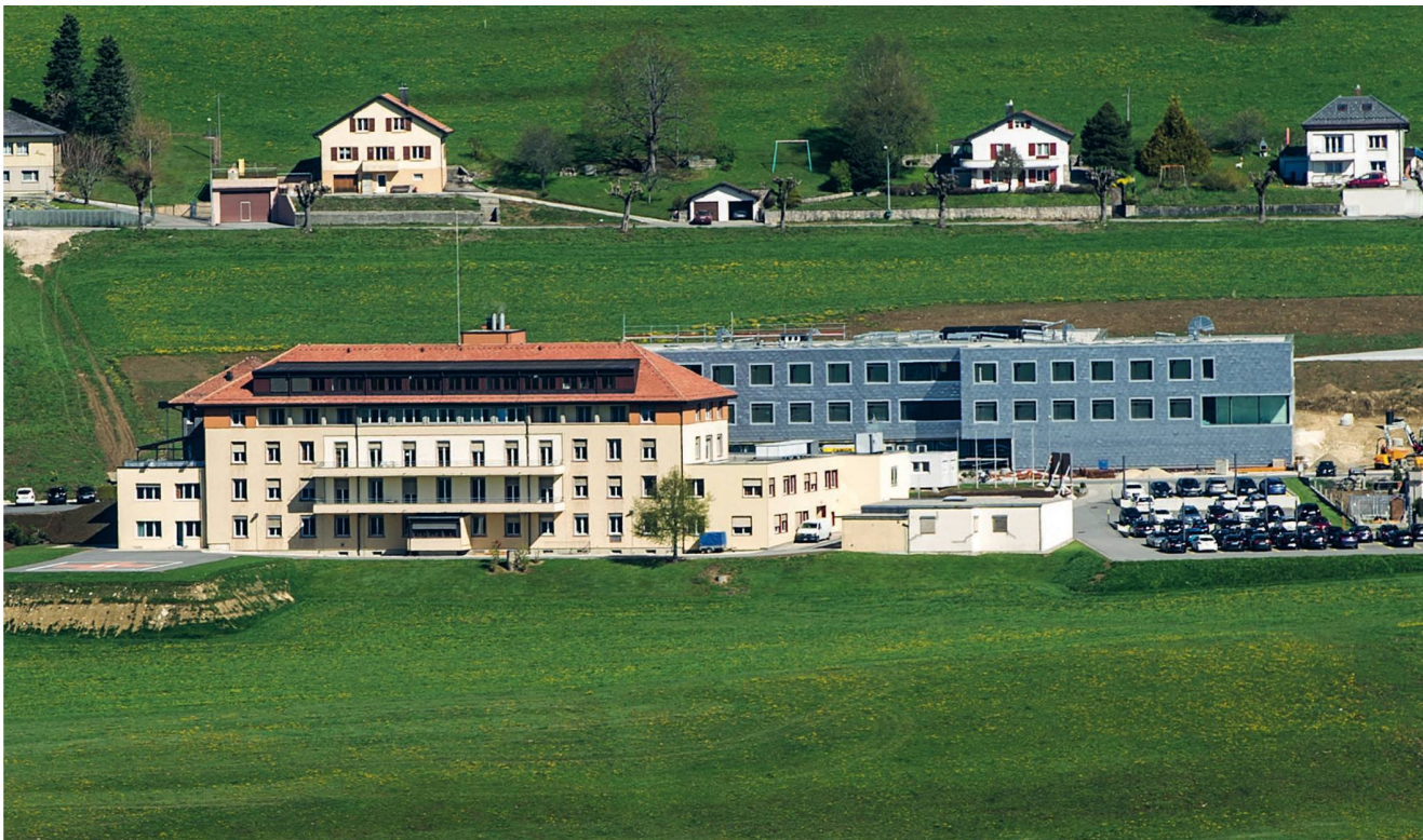
Le site Les Rosiers du Réseau Santé Balcon du Jura.vd, avec au premier plan l'hôpital et à l'arrière le nouvel EMS qui accueillera septante résidents dès l'automne.
