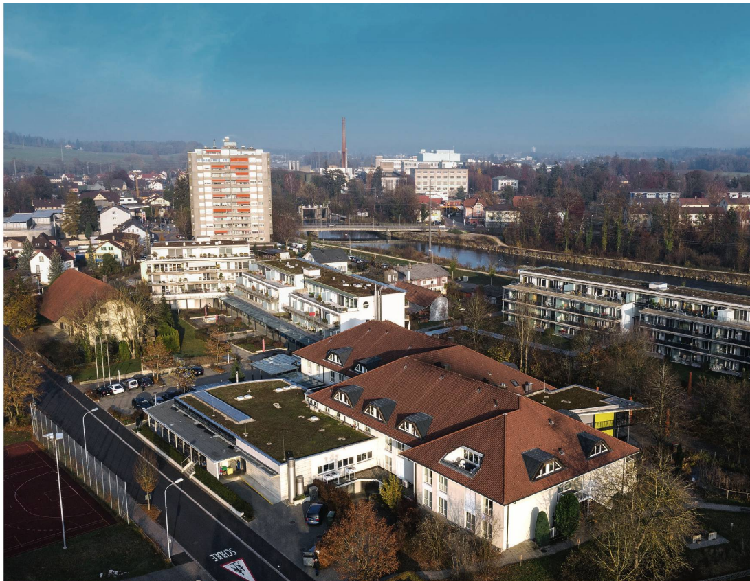
«Läbesgarte» à Biberist: habitat protégé, espaces communautaires, restaurant public et événements pour tout le village.
