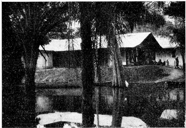
Ansicht vom Flusse aus
