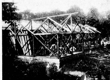
Bau des Hauses für Schwerkranke
