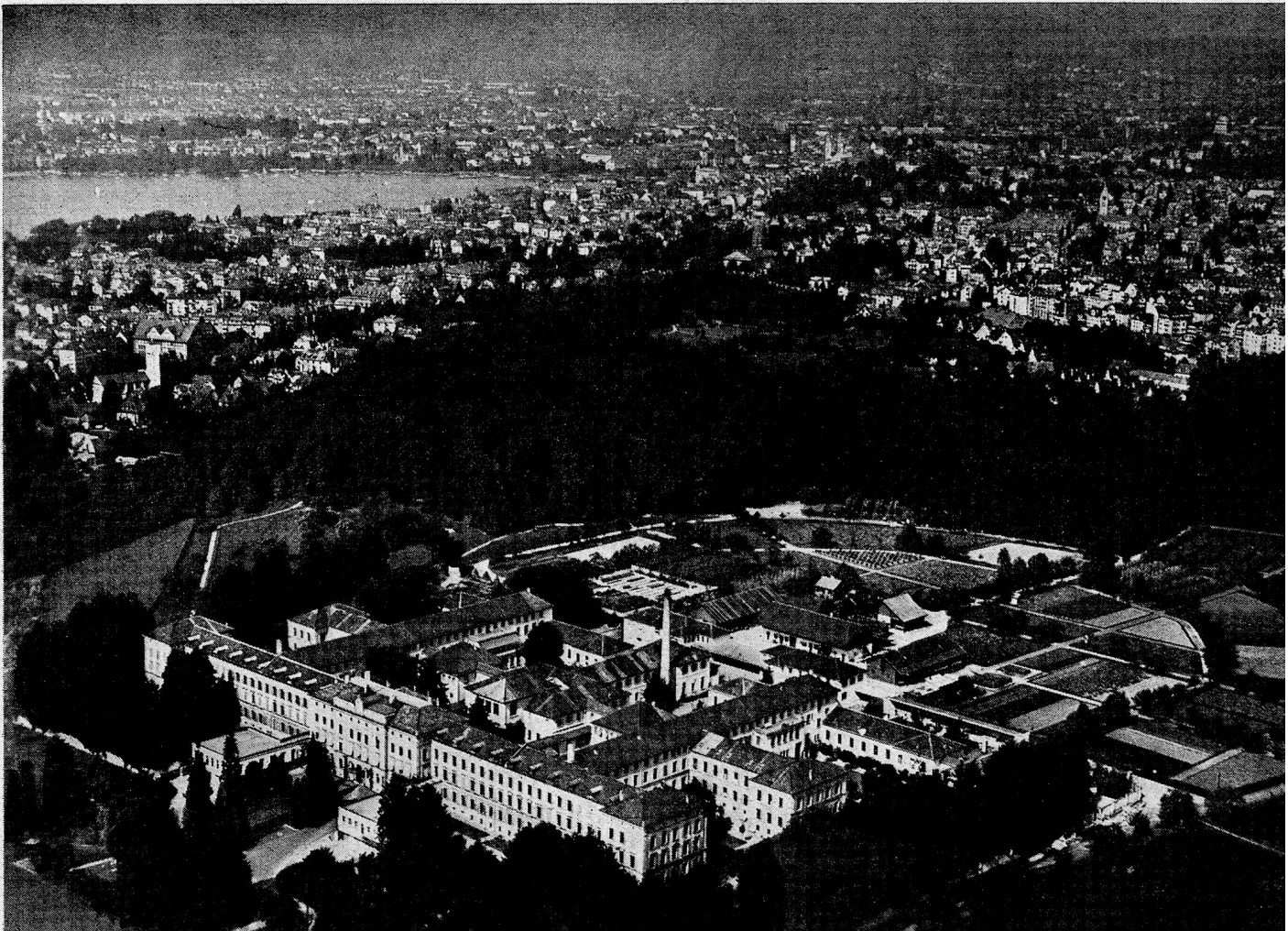
Kantonale Heilanstalt Burghölzli, Zürich 8
