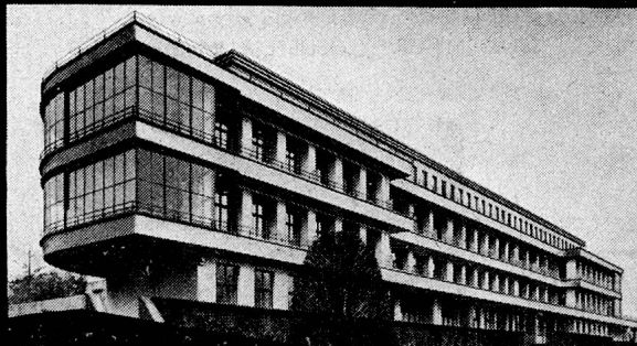
Inselspital Bern Selbsttätige Heizregelanlage System Landis & Gyr
