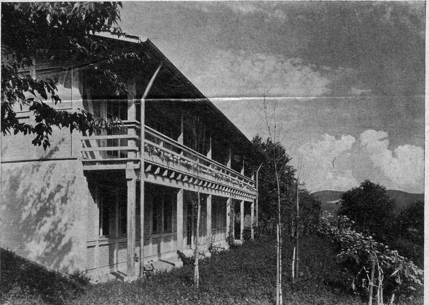
Zöglingsspavillon, Landheim Erlenhof, Reinach (Bld.)
