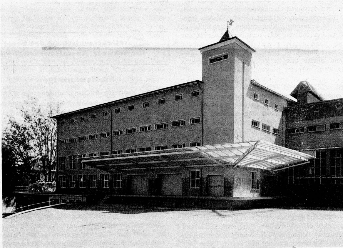
Die neue ROCO-Confitürenfabrik von der Hofseite gesehen.
