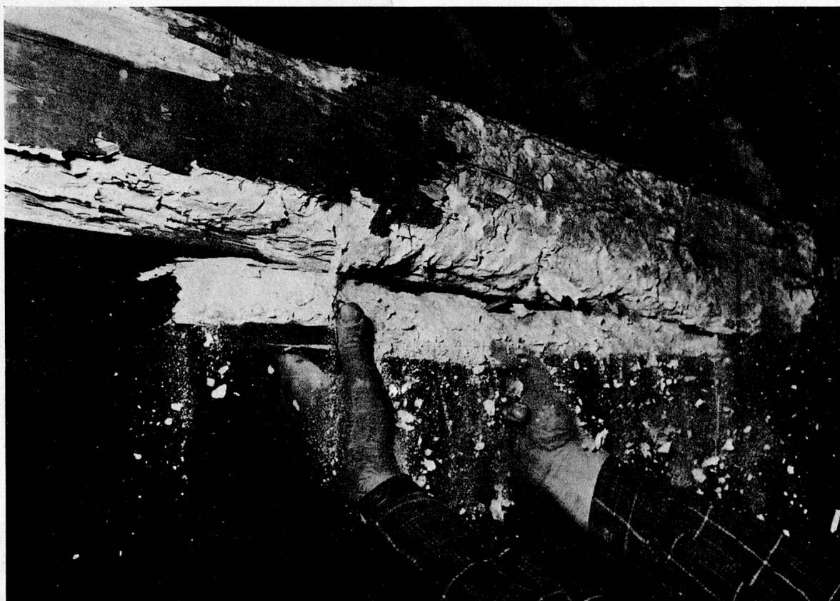
Schaden des Hausbocks in einem Dachstock
