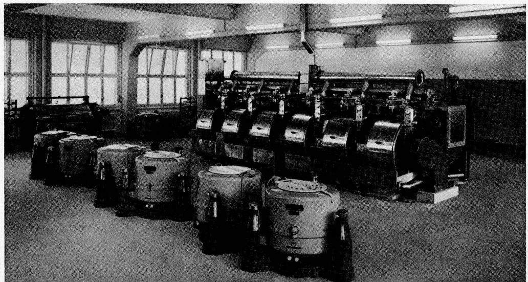
Wäschereianlage Kantons-Spital Winterthur
