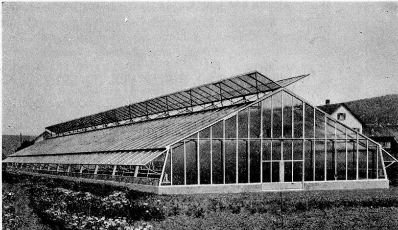
Gewächshausblock für Rosenkulturen 12.00 x 41.00 m mit beidseitigen durchgehenden First- und durchgehenden Stehwand - Lüftungen, zentral bedienbar. Warmwasser-Heizung mit Heizröhren, erstellt für Herrn Rudolf Schneebeli, Handelsgärtnerei, Affoltern a. A.
