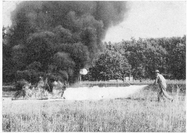
Löschung eines Testfeuers (10 Liter Benzin in einer Wanne von 1 m<sup>2</sup> Grundfläche) mit einem Staub-Handfeuerlöscher.
