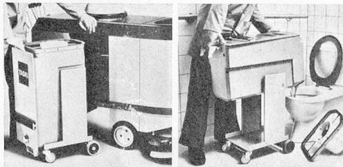
**Neu und einzigartig:** Ausfahrbarer Schmutzwassertank, der mühelos in Ausgussbecken, WC usw. entleert werden kann.
