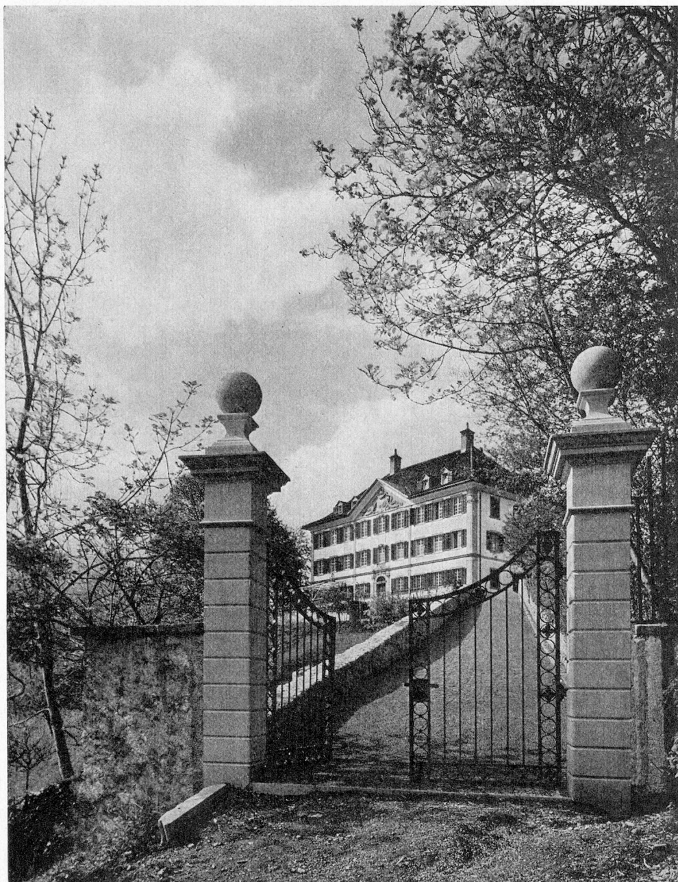
Das wunderbar gelegene Sonderschulheim Haltli in Mollis ist in einem unter Denkmalschutz stehenden Herrenhaus untergebracht.
