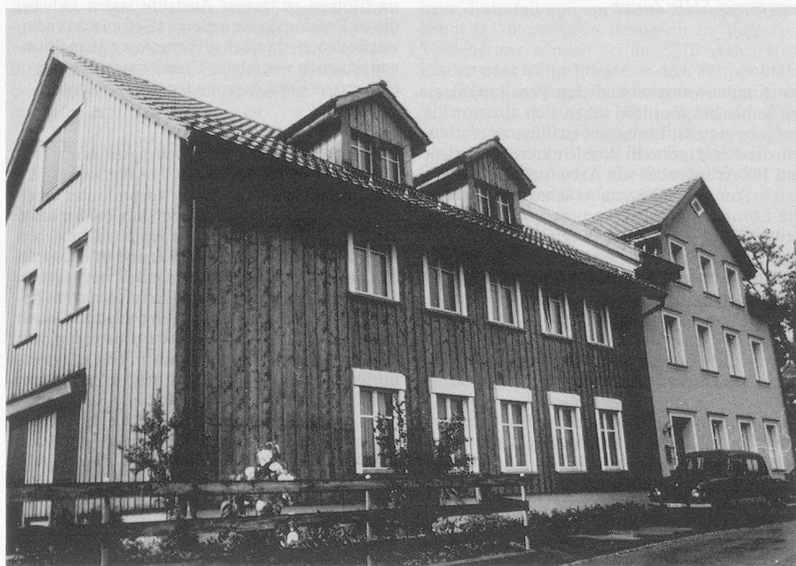
Schulheim Hofbergli: Nach dem Erwerb der ehemaligen Wirtschaft «Sonnenhügel» durch das Schulheim Hofbergli, Rehetobel AR, wurde das Gebäude an der alten Landstrasse um einen Schultrakt samt Saal erweitert. (Bild P. E.)
