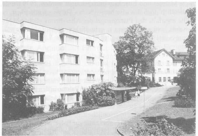
Das Altersheim Schönbühl nach der Renovation 1988/89 (beide Häuser).
