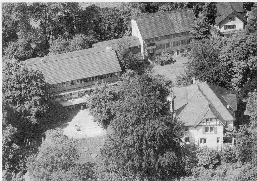
Das Kinderspitäli; hinten die beiden Heim-Trakte, im Vordergrund das Personalhaus mit Schule und Physiotherapie im Erdgeschoss.
