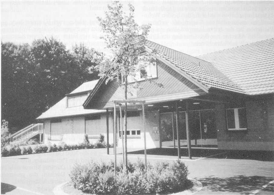
Das weit auskragende Dach der Vorfahrt.
