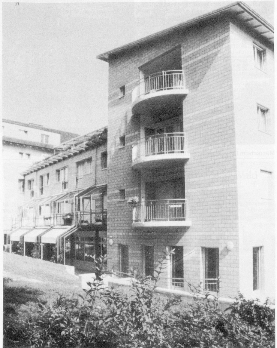
Erweiterungsbau des Tabeaheims, 1991–1993.
