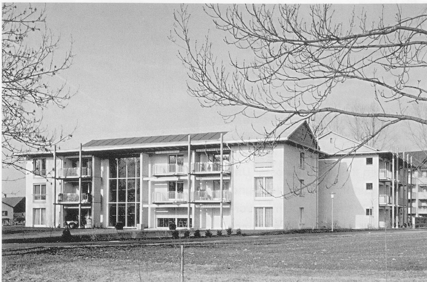
Zwei der drei Manau-Blöcke, auf dem Dach 39 m 2 Sonnenkollektoren.
