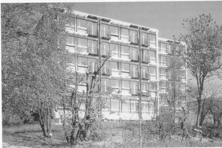
Neues Gesicht und neues Innenleben – neue Alterswohnungen: Das Heim selber (links) wurde totalsaniert und erhielt mit einer neuen, vorgezogenen Fassade bedeutend grössere Zimmer, neu dazu kam die Alterssiedlung mit den Alterswohnungen. Im Bild nicht sichtbar ist der derzeit im Bau befindliche Trakt für die Wohngruppe, welcher südlich mit einer direkten Verbindung an das Heim anschliesst. Foto Heim zVg
