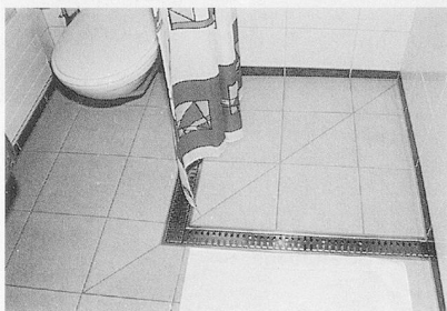
Resitec-Duschrinne, eingebaut in eine befahrbare Eckdusche.
