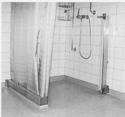
Eckdusche mit einem BRUWAS Wasserstop-System.
