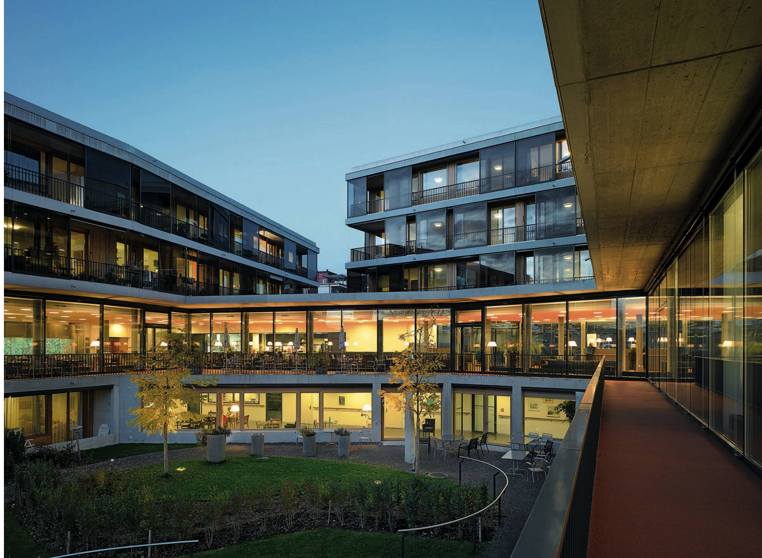
Ökologie und Ästhetik vereint: Das Alterszentrum Lanzeln in Stäfa mit glasverkleideten Balkonen. Ein geschützter Demenzgarten gehört ebenso dazu wie grosse, luftige Räume mit Blick auf den Zürichsee.
