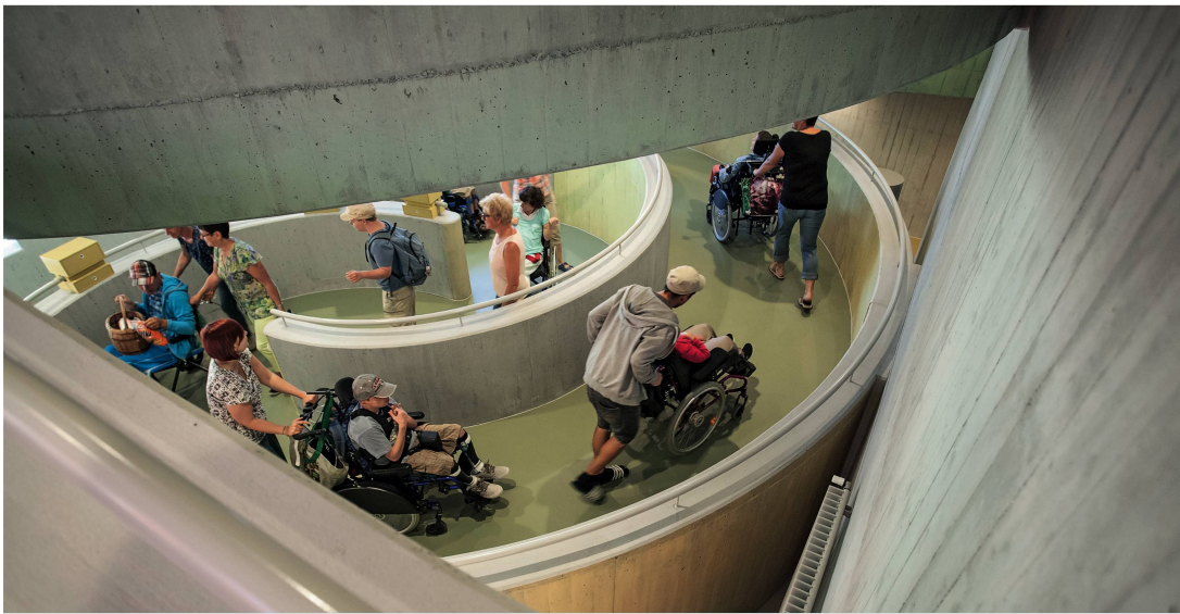
Komplett barrierefrei: Das vierstöckige Bauwerk ist mit einem spiralförmig angeordneten Rampensystem durchgehend verbunden.
