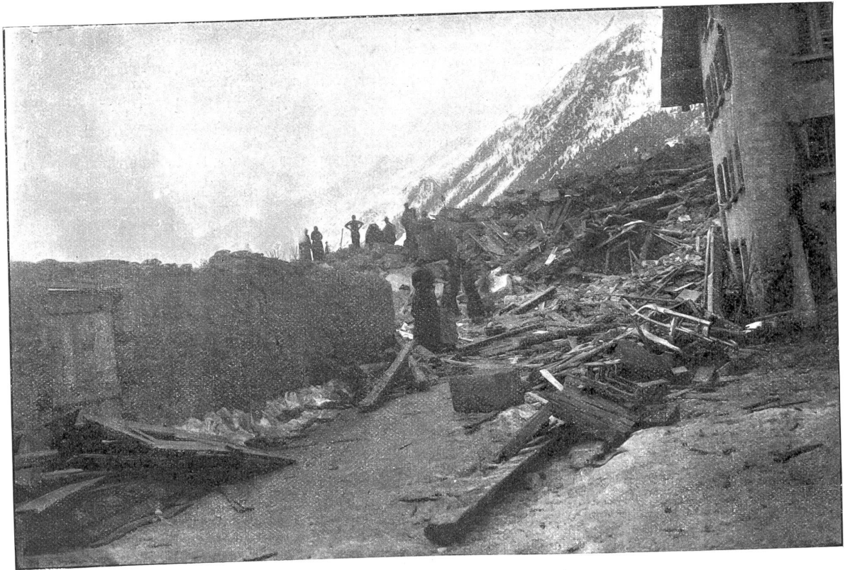
Die verschüttete Gotthardstraße. Phot. J. Gafler, Andermatt.
