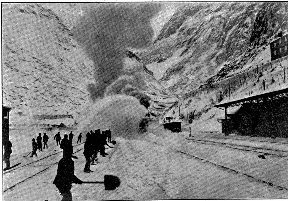
Die Schneeschleudermaschine der Gotthardbahn. Vergl. Text S. 161.
