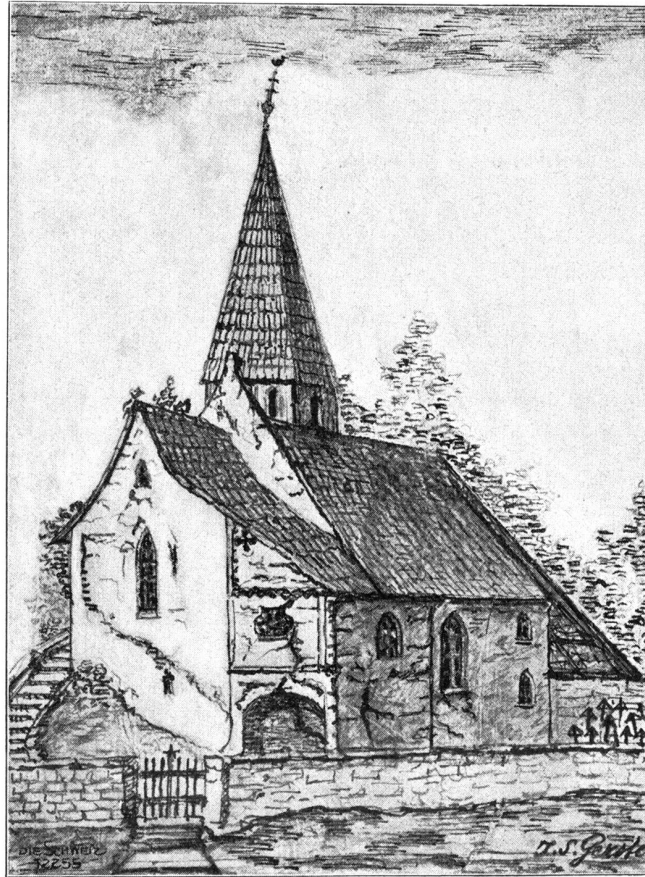
Die alte Pfarrkirche in St. Margrethen vor der Renovation. (Zeichnung von J. S. Gerster.)
