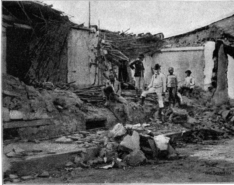
Erdbeben in Caracas am 29. Oktober 1900: Eingestürztes Haus.
