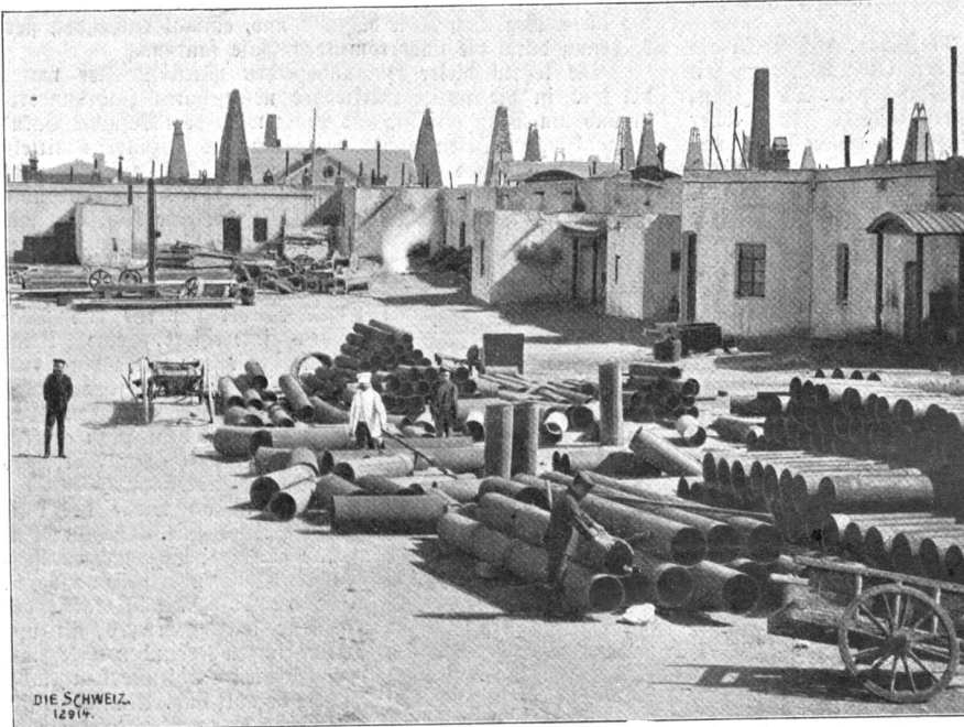
Mechanische Werkstätte zur Herstellung der Bohrröhren in Balachané.
