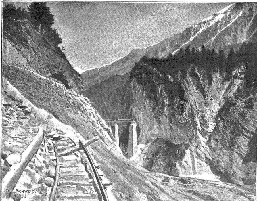
Ueberbrückung der Landwasserschlucht mittelst Viadukt von 130 m Länge und 65 m Höhe. (Phot. A. Krenn, Zürich).
