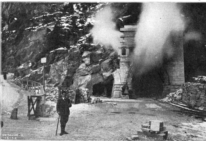
Oberingenieur Konrad Piffel vor dem Tunnelportal bei Zelle.
