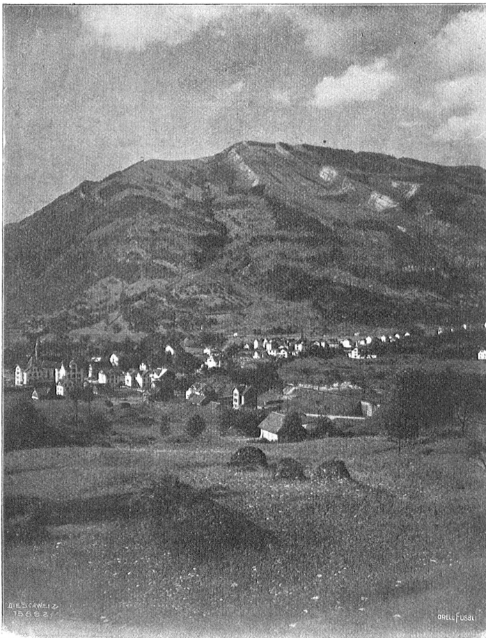
Goldau gegen den Roßberg; oben die Abbruchstelle.
