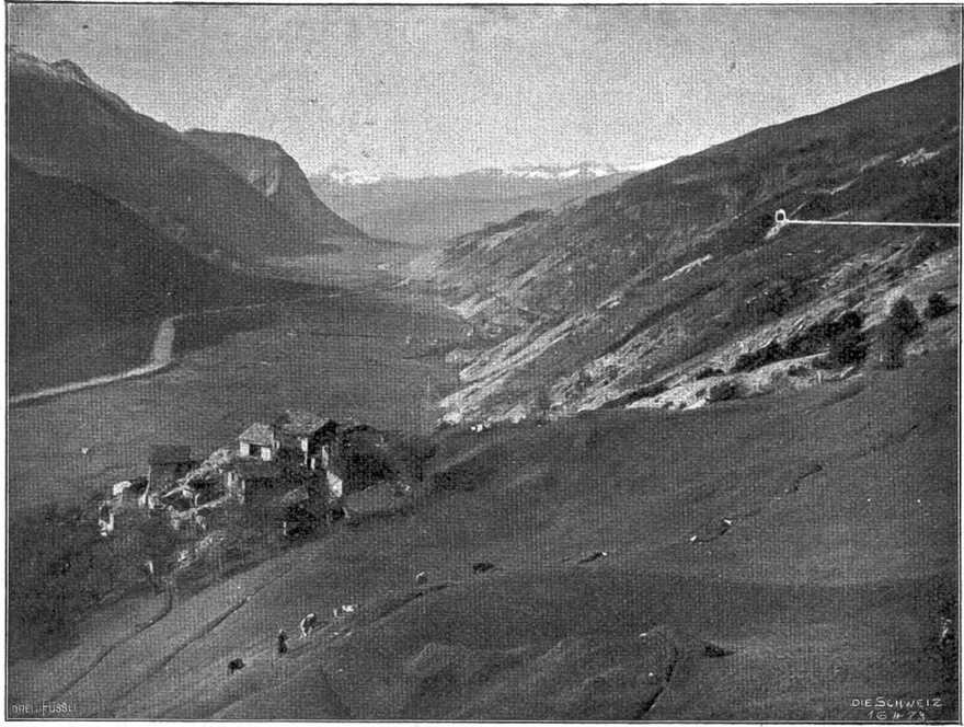
Von der Lötschbergbahn. Blick von der im Bau befindlichen Strecke ob Maron gegen das Unterwallis bis Sitten.
