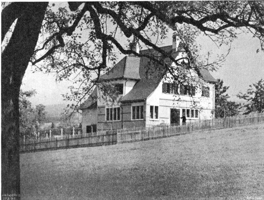
Streiff & Schindler, Zürich. Wohnhaus von Architekt G. Schindler in Bellikon bei Zürich, erbaut 1907.
